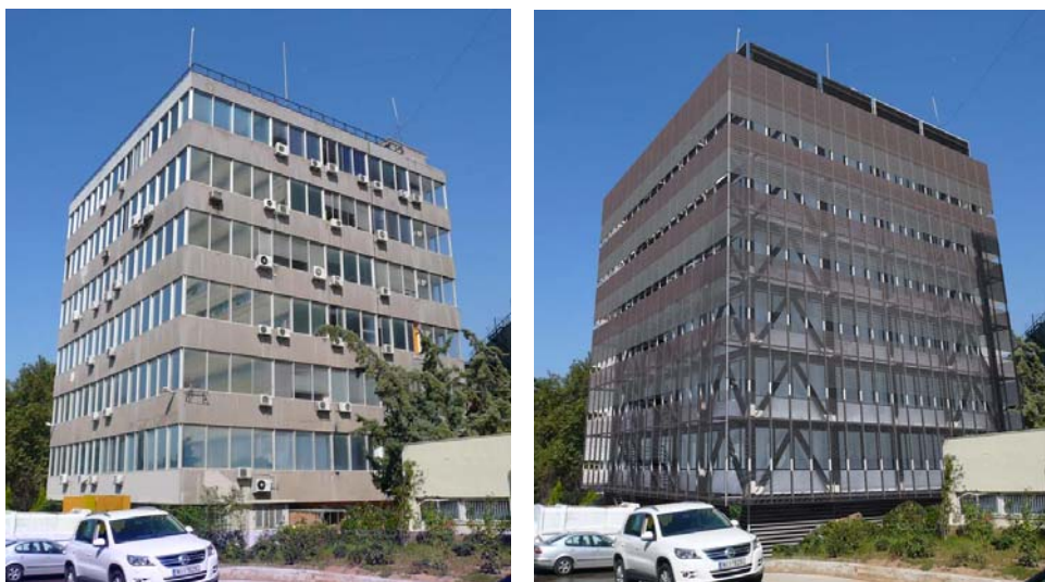
Σχήμα 7. Υφιστάμενο και ενισχυμένο κτίριο (φωτορεαλιστική απεικόνιση).
