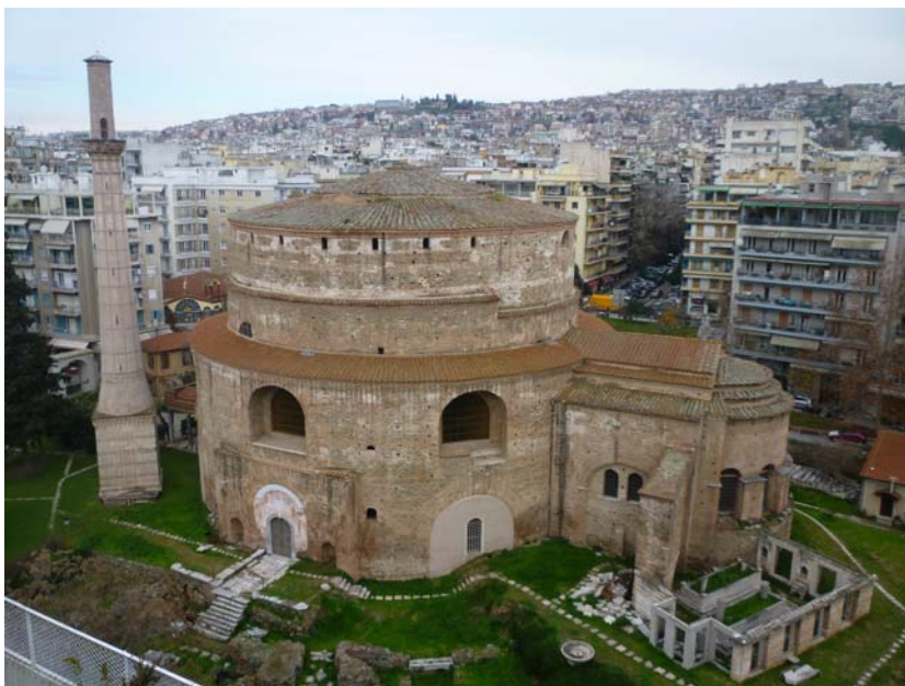
Εικόνα 5. Αποψη της Ροτόντας από τα νοτιοανατολικά
